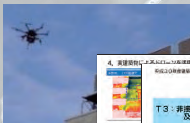
ドローン撮影実証実験
